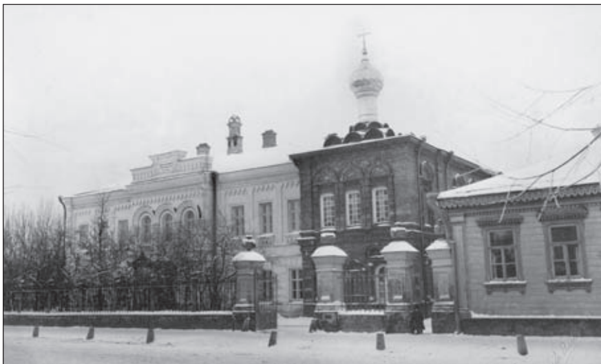
Здание Аваевской больницы на 1-й Никольской улице
